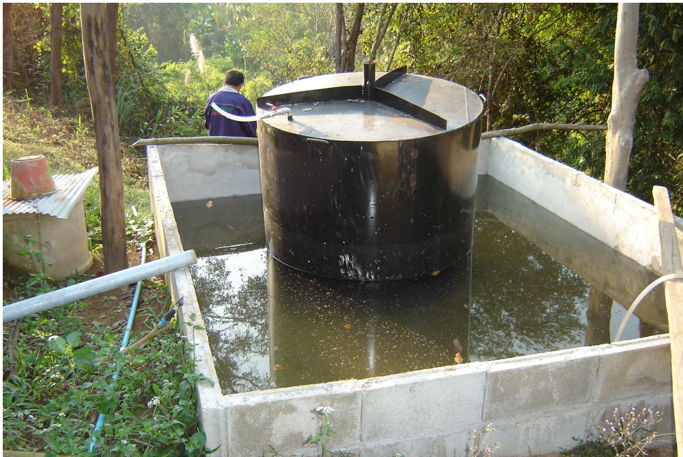
การสร้างบ่อแก๊สโดยใช้ซีเมนต์บล็อกทำเป็นบ่อใหญ่เป็นรูปสี่เหลี่ยมเพื่อใช้ในการเลี้ยงปลา
