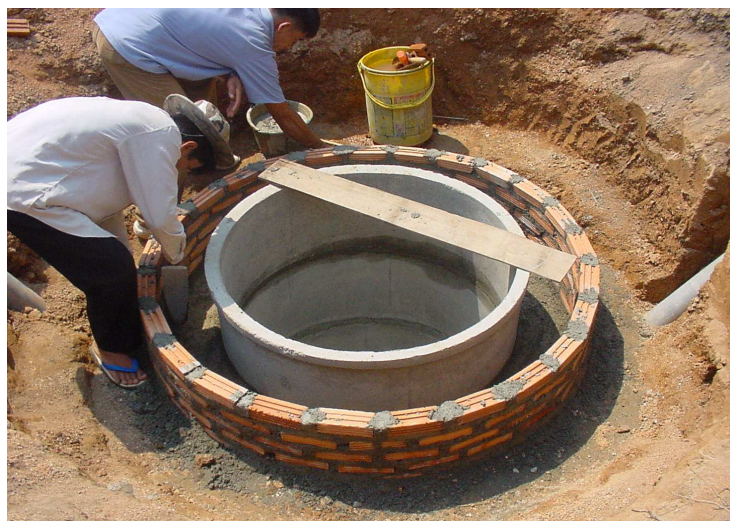
ภาพการสร้างบ่อแก๊สแบบใช้อิฐแดงก่อเป็นบ่อชั้นนอก
