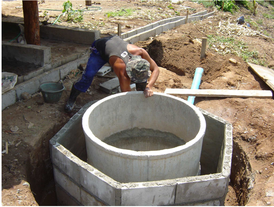
การสร้างบ่อแก๊สโดยใช้ซีเมนต์บล็อกทำบ่อใหญ่(6เหลี่ยม)
