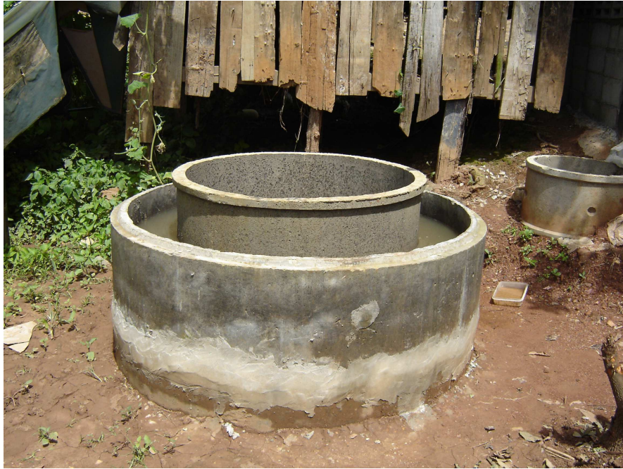
การสร้างบ่อแก๊สโดยการใช้ถังคอนกรีตสำเร็จรูปในการทำบ่อใหญ่
